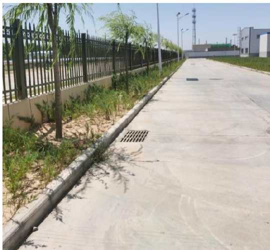
园区地面硬化和雨水进水口
