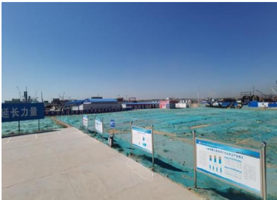
园区临时苫盖
