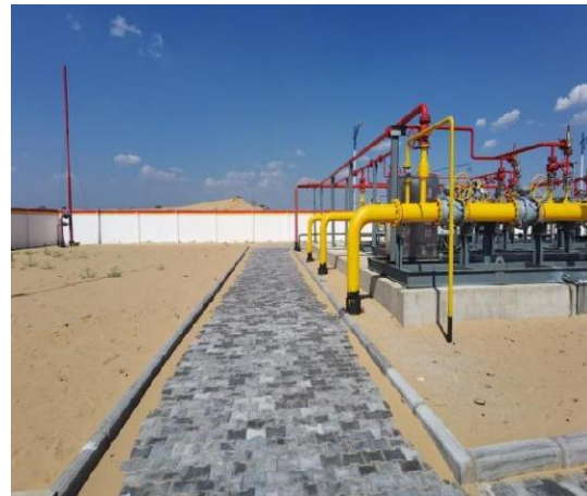
园区正建设项目
