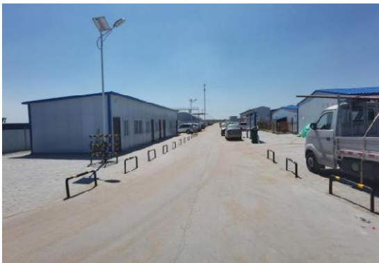
现有建设项目临时施工生产生活区
