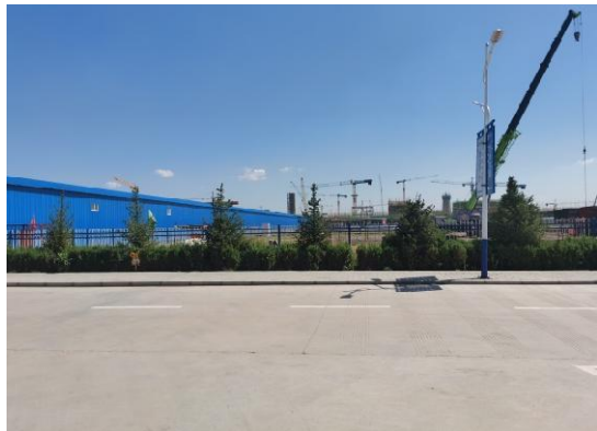
园区地面硬化
